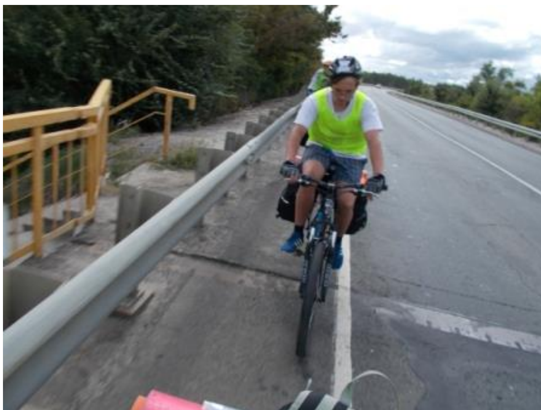
Фото 52, обьездная дорога Петровска, эстакада над ж/д путями на дороге Р158, перед перекрестком и поворотом на пос.1-я Березовка
