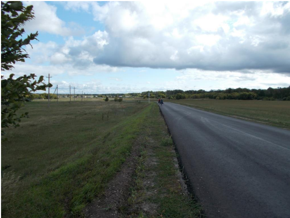
Фото 54, к пос. 1-я Березовка и дальше до пос. Сосновка 1-я положен новый асфальт, получили большое удовольствие от проката по этому участку, трафик слабоинтенсивный
