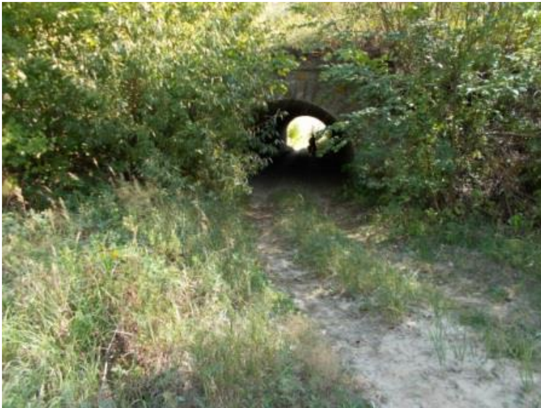
Фото 98, проезд под ж\д виадуком, старое каменное сооружение, вроде 1896г. Эта ж/д ветка доходит до г. Калининска и заканчивается на местном элеваторе
