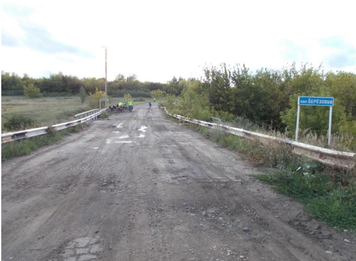
Фото 55, мост через овраг Березовый сразу после пос. 1-я Березовка
