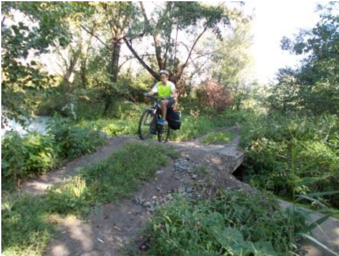
Фото 80, старые гидротехнические сооружения, видимо отстойники, судя по запаху, р-н с. Новая Осиповка
