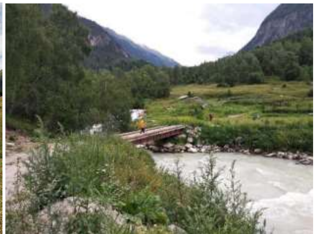
Фото 14. Мост через реку Кубань
